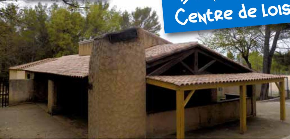
Les toitures de la salle, de l'auvent et des vestiaires de la Garenne ont été remises à neuf (isolation et couverture de tuiles).
