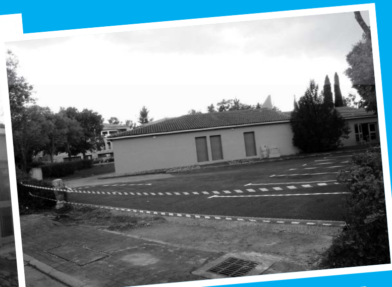
Réfection du foyer des aînés
