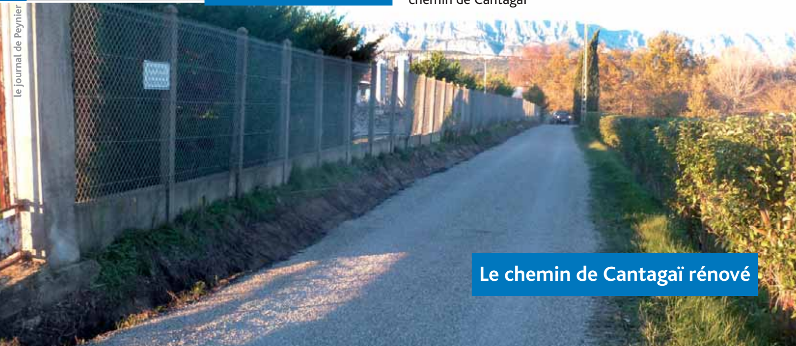
Pendant les travaux
